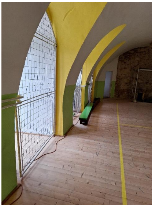
Obrázek 8 – mříže v tělocvičně
